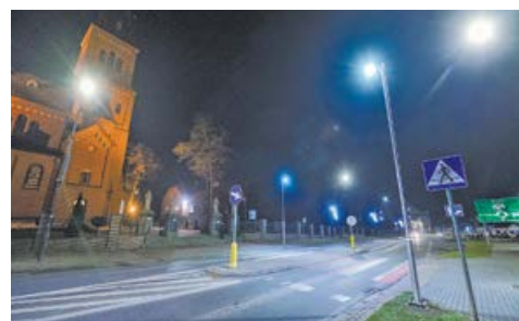
DOŚWIETLENIE PRZEJŚĆ UL. KOŚCIELNA 1
