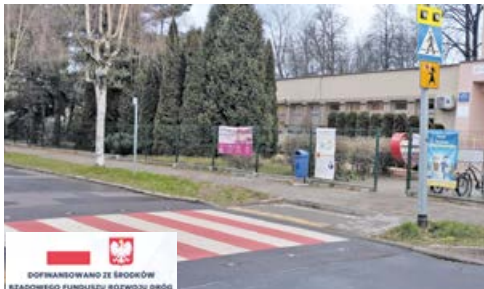
PRZEJŚCIA DĄBROWSKIEJ PRZY SP NR 4
