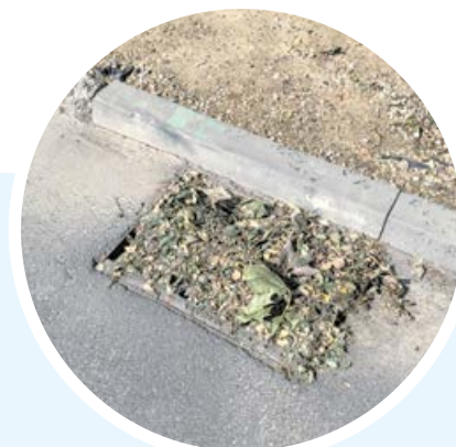
Zbiornik przy ul. Innowacyjnej
