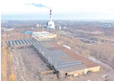
ROZWÓJ MIASTA BUDOWA NOWOCZESNEJ WALCOWNI
