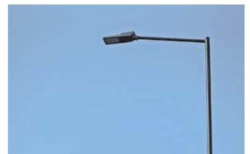
MODERNIZACJA MODERNIZACJA OŚWIETLENIA
