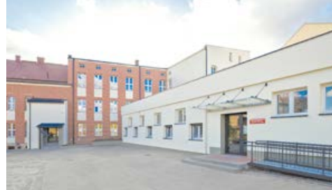
FOTOWOLTAIKA ZESPÓŁ SZKÓŁ TECHNICZNYCH I OGÓLNOKSZTAŁCĄCYCH MERITUM
