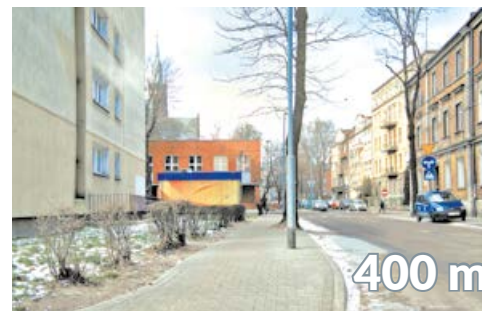
CHODNIK, OŚWIETLENIE I BRAMA WJAZDOWA, NAWIERZCHNIA PLACU SZKOLNEGO SP11
