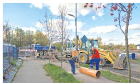
REMONT KANALIZACJI DESZCZOWEJ DOMINA
