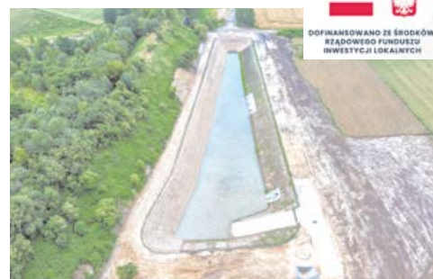
MODERNIZACJA BUDOWA ZBIORNIKA RETENCYJNEGO
