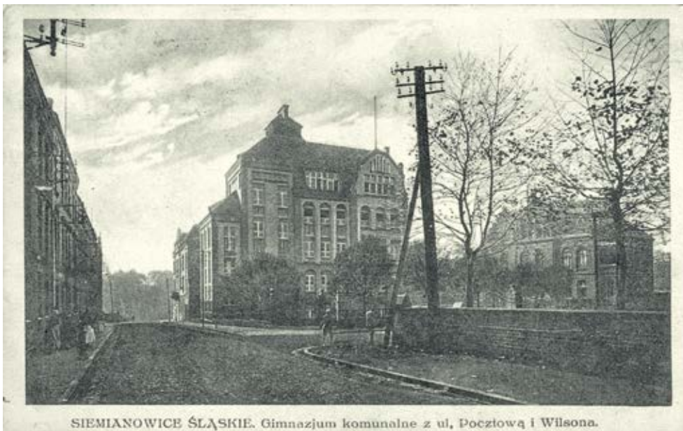
Budynek szkoły przed przebudową
