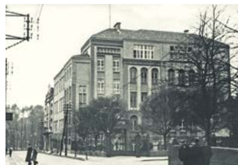
Budynek szkoły po przebudowie
