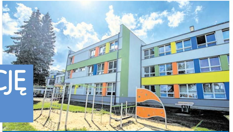
W ubiegłym roku zakończono termomodernizację SP 1.
