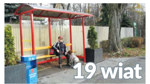
USPRAWNIENIA DROGOWE ZAKUP I MONTAŻ WIAT PRZYSTANKOWYCH
