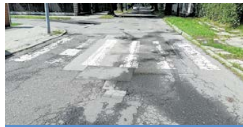
Po wymianie nawierzchni al. Sportowców skończy się uciążliwy dojazd do Parku Pszczelnik.
