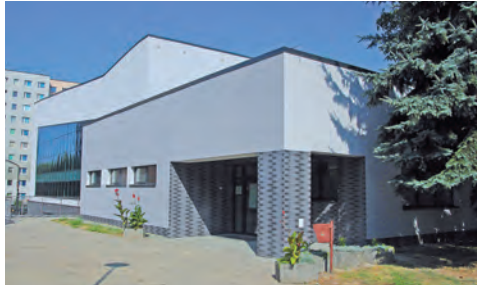
DOCIEPLENIE BUDYNKU ŚLĄSKA 18
