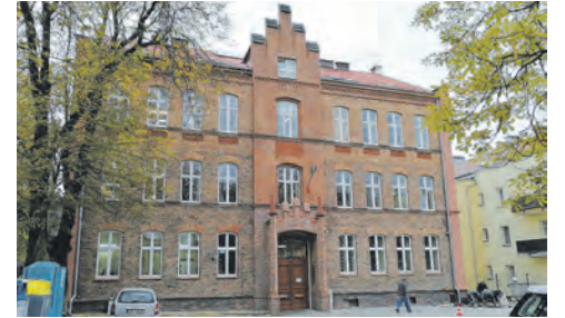
REMONTY KLATKI SCHODOWE
