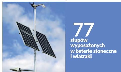
USPRAWNIENIA DROGOWE BUDOWA NOWOCZESNEGO OŚWIETLENIA OZE
