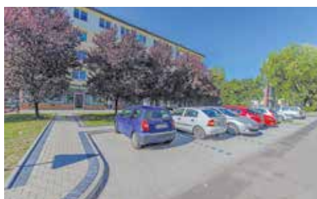
Wykonanie nowych miejsc parkingowych, i nawierzchni chodnika ul. Andersa
