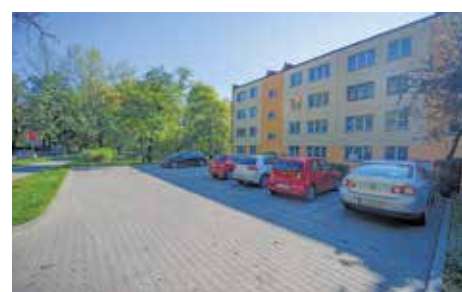
Wymiana nawierzchni chodnika, ul. Sikorskiego 1 oraz Andersa 10
