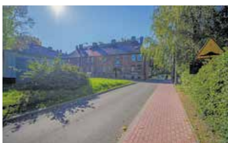
Wymiana nawierzchni drogi oraz budowa chodnika przy ul. Trafalczyka
