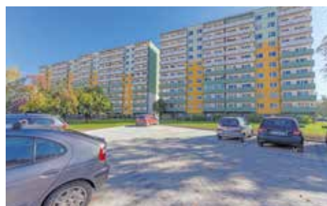
Budowa parkingu przy ulicy Niepodległości - SCK
