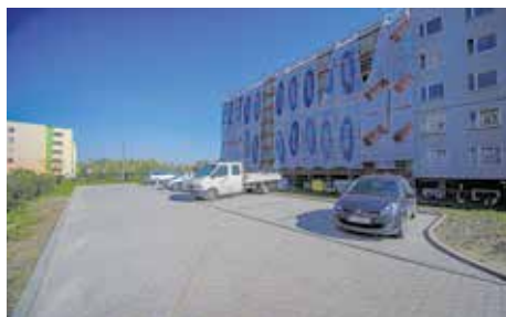
Wykonanie miejsc postojowych ul. Budryka 6 i 8
