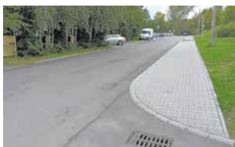
Remont chodnika przy ul. Kruczej 2a
