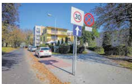
Wykonanie chodników oraz modernizacja miejsc postojowych i lamp przy ul. Stawowej
