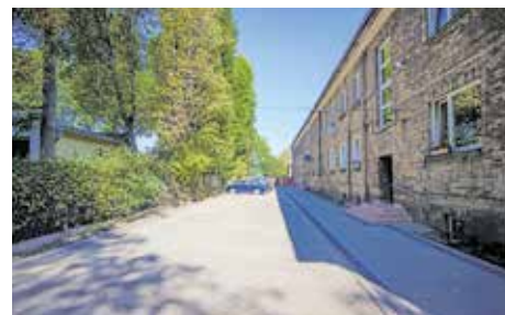
Rewitalizacja osiedla (budowa parkingów) ul. Bytomska 33 - 39
