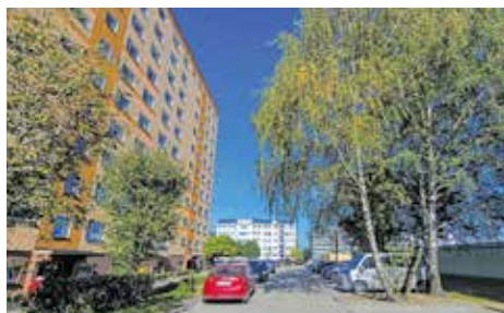
Budowa parkingu przy ul. Wyzwolenia 19
