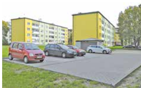
Budowa parkingu przy ul. Kołodzieja 4
