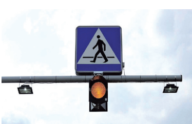
SYGNALIZACJA ŚWIETLNA WYMIANY I MONTAŻE STEROWNIKÓW
