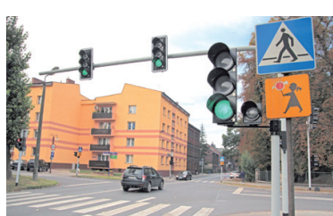
SYGNALIZACJA ŚWIETLNA ZMIANA I KOREKTY PROGRAMU SYGNALIZACJI
