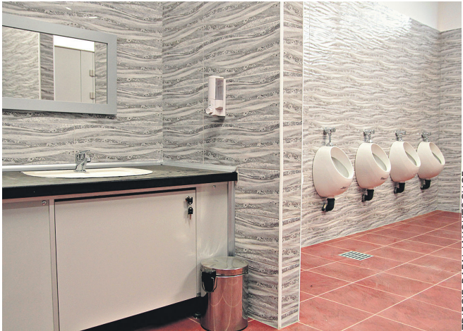
Kończy się remont węzłów sanitarnych w Gimnazjum nr 4, które po wakacjach będzie Szkołą Podstawową nr 6.
